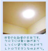
珪藻土天井施工例
